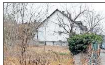
Derzeit Brache: Hotelgrundstück Waldstraße ARCHIVFOTO: LENZ
